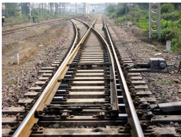
a) 铁路道岔
