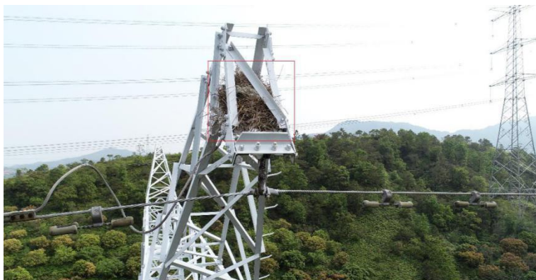
图 20 输电设备异物检测
